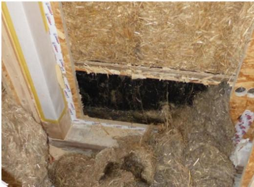
Dämmung aus Hanf und Stroh
